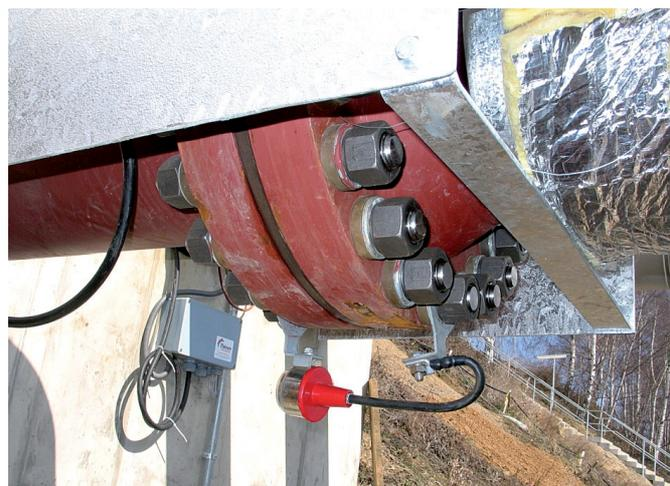
**Bild 4** Beispiel für den Einbau einer typgeprüften Ex-Trennfunkstrecke an einem Isolierflansch.
