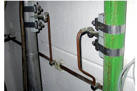
**Bild 6** Beispiel für die Anwendung einer typgeprüften blitzstromtragfähigen Ex-Bandrohrschelle.
