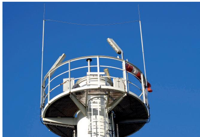
**Bild 3** Beispiel für die Positionierung von zwei Fangstangen und einer gespannten Leitung als Fangeinrichtung in Ex-Zone 2 und 22.
